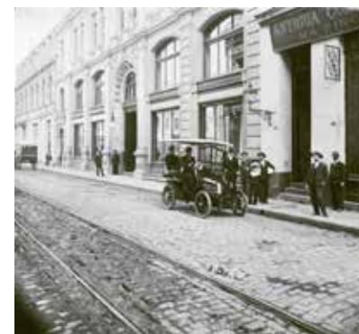
Fig. 11 Pavimento de adoquín y automóvil en la década de 1900, Santiago. Fuente: Archivo Fotográfico, Museo Histórico Nacional (Fb-5006). / Cobblestone paving and car in the decade 1900, Santiago. Source: Photographic archive, Museo Histórico Nacional (Fb-5006).
